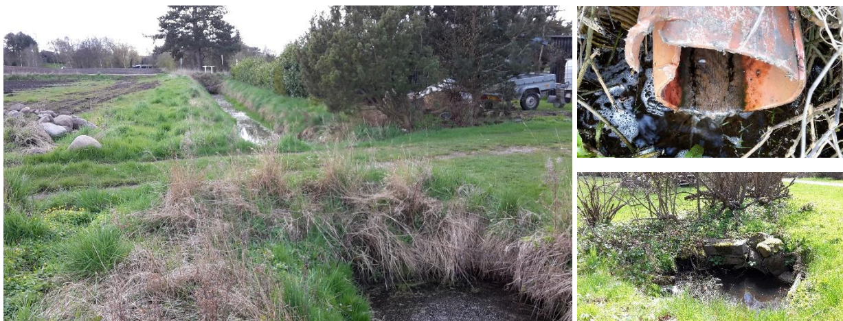
Sektion 5 ved Havnemarken med udspring i lille bassin ved Lindevej i Bjerge Nordstrand. Indskudt foto øverst er snasket punktkilde fra sommerhusområde, der løber til opstrøms lille vej nord for Havnemarken (overfor hvor stort foto er taget).
